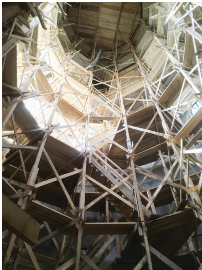
Vedere din interiorul schelei ridicată în Turla Centrală
