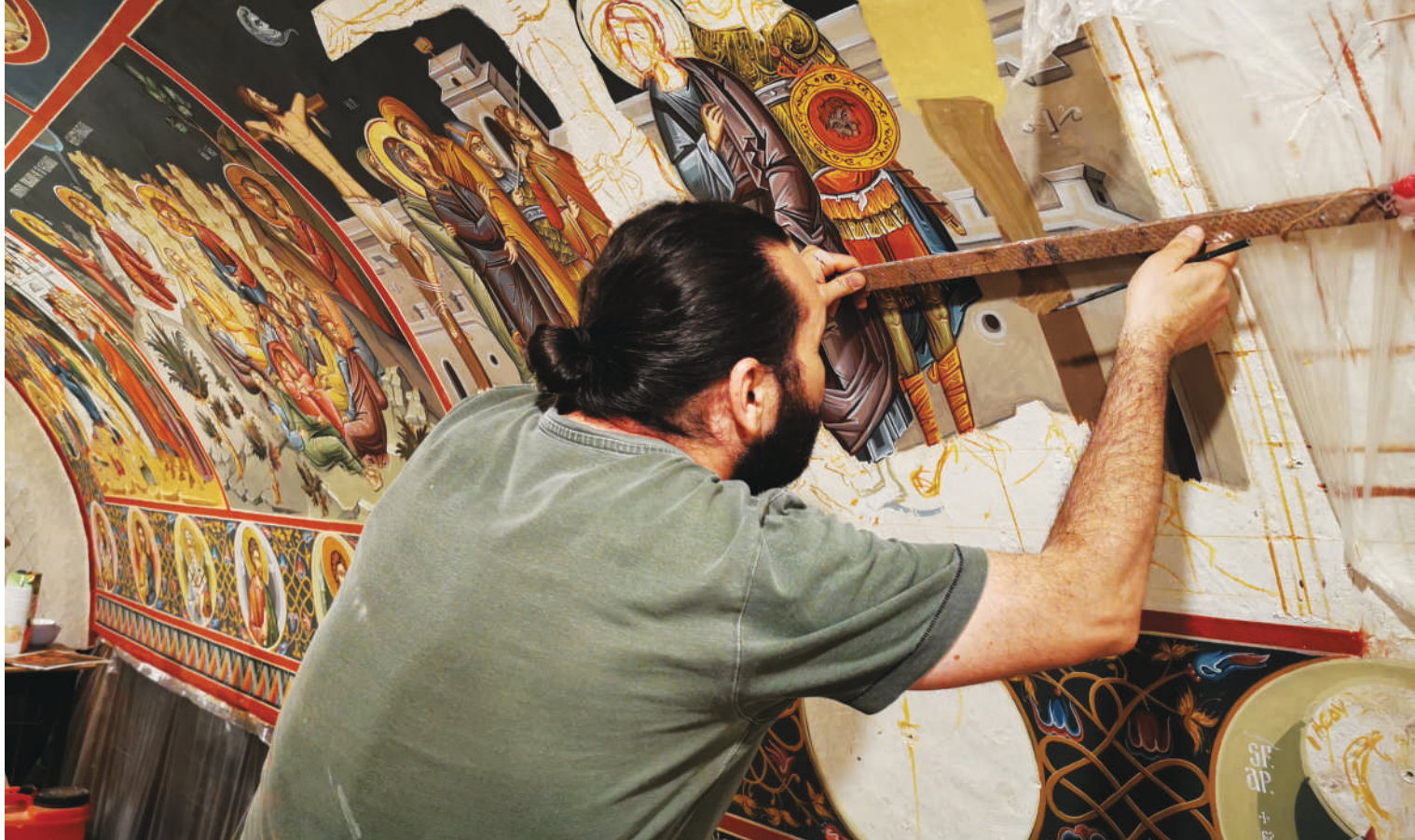
Capela „Sf. M. Mc. Mina și Sf. Cuv. Maxim Mărturisitorul”, - Arad - Imagini din timpul lucrului - Frescă
